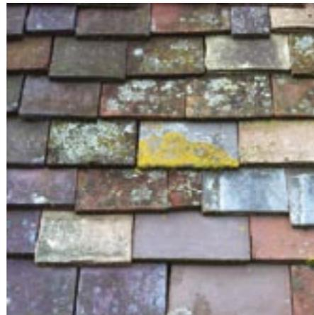
La densité de ces tuiles se situe aux environs de 70 ou plus au m<sup>2</sup>, avec un pureau d'au moins 1/3, ce qui assure une bonne étanchéité au bâtiment et préserve un aspect de finesse et de souplesse aux toitures percheronnes.
