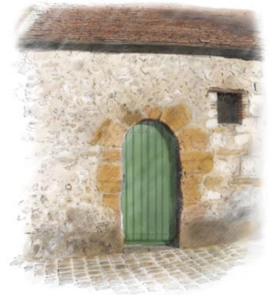
**Appareil, appareillage** : façon de disposer les pierres ou les briques dans la construction d'un mur : régulier, mixte (plusieurs matériaux), oblique (arête de poisson). Le terme d'appareil s'applique aussi au format de la pierre : grand appareil (minimum 70 x 40), petit appareil, etc.
