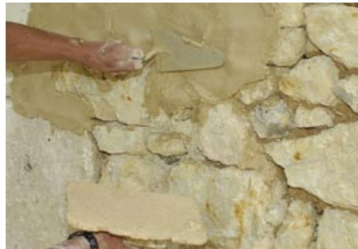
L'enduit ne doit pas être en retrait des pierres de chaînage ou de jambage, sauf lorsque cette disposition fait partie de la conception architecturale originelle. Il ne doit pas non plus créer de surépaisseur mais s'amortir au nu de la pierre ou de la brique. Dans le cas de surfaces irrégulières, l'enduit ne doit pas être le moyen artificiel de redresser le mur par surépaisseur. Il doit au contraire suivre les mouvements de la maçonnerie sans l'alourdir ou lui donner un aspect moderne et rigide.
