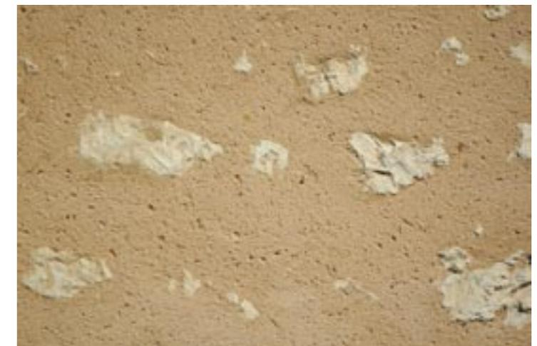
Appareillage de moellons calcaires avant et après la réalisation d'un enduit dit « à pierres vues »
