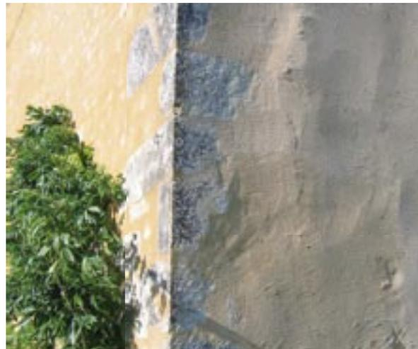
La méthode traditionnelle consiste ensuite à appliquer le mortier de chaux en trois couches ou trois « passes » de façon manuelle :
