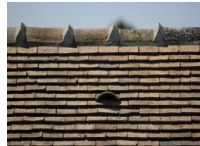
Sur les toitures anciennes la zinguerie est très peu présente, exceptée sur certains toits d'ardoises où elle joue parfois un rôle décoratif. D'une façon générale, les pièces métalliques et les noquets doivent être invisibles. Il faut pour cela préférer les noues fermées, les solins de mortiers au contact des murs et les faîtages traditionnels faits de tuiles demi-ronde scellées à crêtes et embarrure de mortier.
