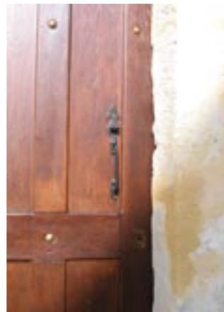
Les menuiseries anciennes épousent la forme des ouvertures pour lesquelles elles ont été réalisées sur mesure. Droit ou courbe, en plein cintre ou en anse de panier, le linteau détermine le travail de la menuiserie. Les fenêtres restent discrètes et respectent ainsi le rythme des percements des murs. Montants et traverses restent fins pour laisser largement pénétrer la lumière.
